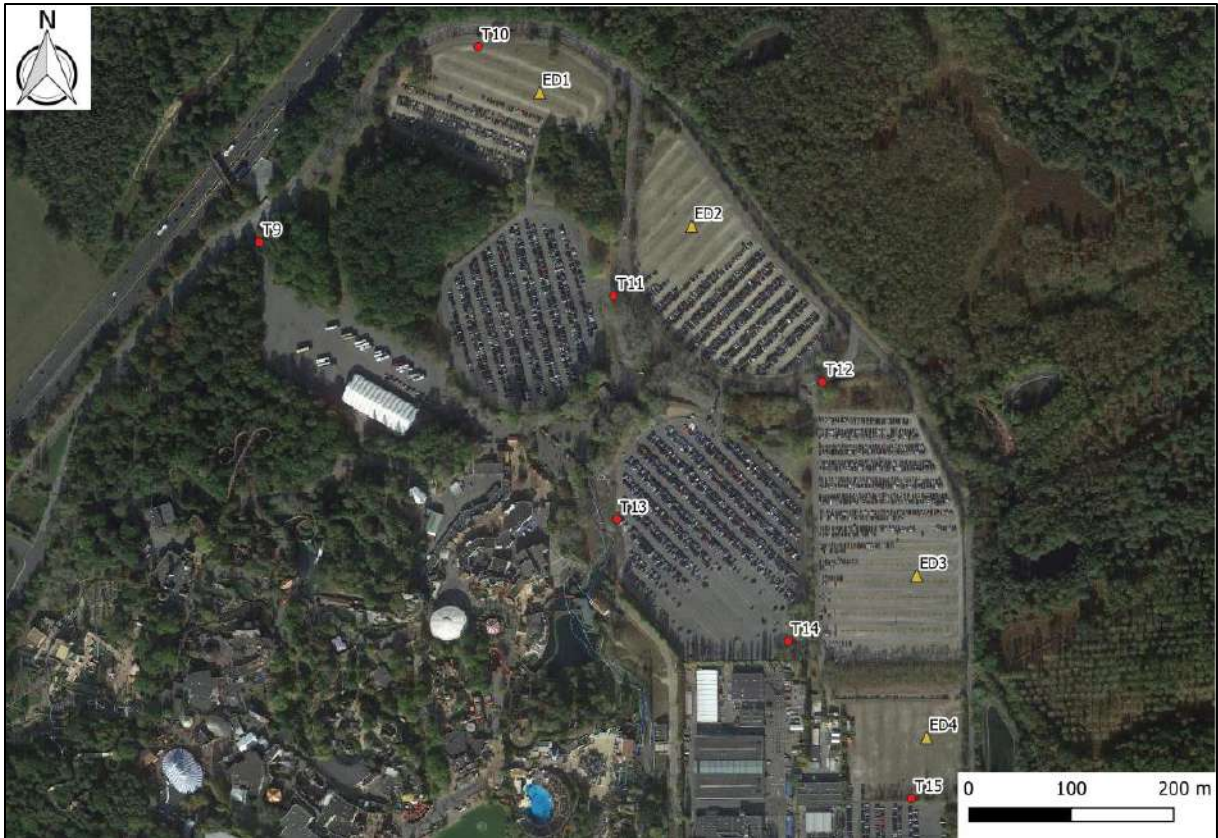
Figure 1 : Zone d'implantation des sondages au droit des parkings [Google Earth]
